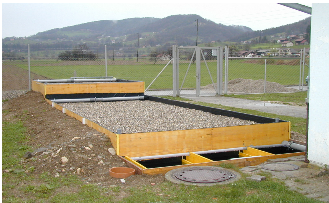
Slika 2: Rastlinska čistilna naprava za čiščenje pitne vode v Rečici (Vir: Arhiv podjetja Limnos, 2005).
